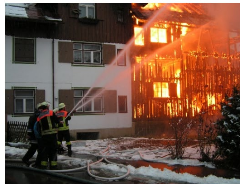
Einsturz der Holzkonstruktion nach Querschnittsverringering des Baustoffs
