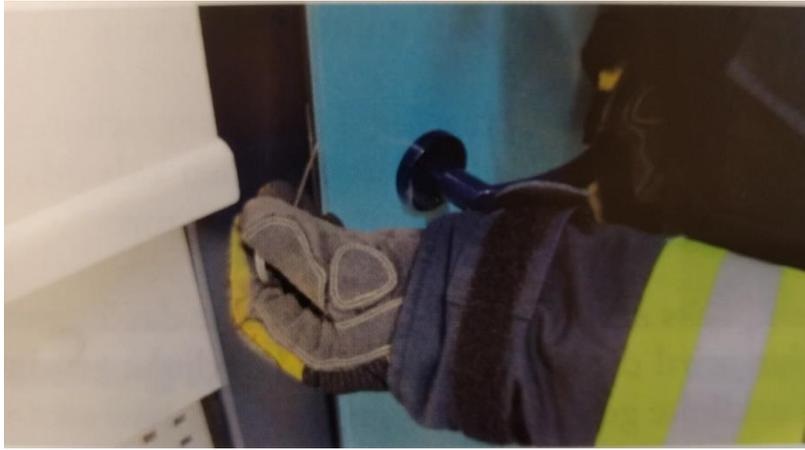
Türfallenhebel in Türfalz oberhalb des Schlosses einführen. Durch zweimalige 90° Drehung gelangt das vordere Teil des Bügels hinter die schräge Seite der Türfalle.
