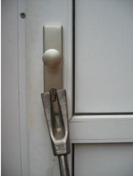
Durch entfernen des Schliesszylinders kann der Schaden an einer zu öffnenden Tür begrenzt werden. Zur erfolgreicher Umsetzung dieser Möglichkeit ist es allerdings notwendig, dass der Zylinder weit genug übersteht, um ihn entsprechend fassen zu können. Zum anschliessenden Aufschliessen der Tür ist ein Neubautenschlüssel und eine Spitzzange erforderlich.
