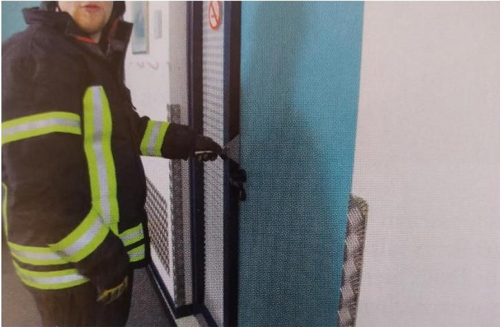
Türfallenblech Richtung Schloss führen unterstützt mit leichten Hammerschlägen. Trifft jetzt die Schräge des Türfallenblechs auf die abgeschrägte Seite der Türfalle und wird weiter nach unten bewegt, so drückt sich die Falle gegen die Federkraft in den Schlosskasten zurück und die Tür öffnet sich.
