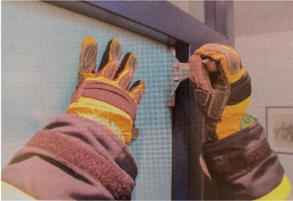
Türfallenblech in Türblattecke einsetzen mit leichtem Druck gegen das Türblatt.
