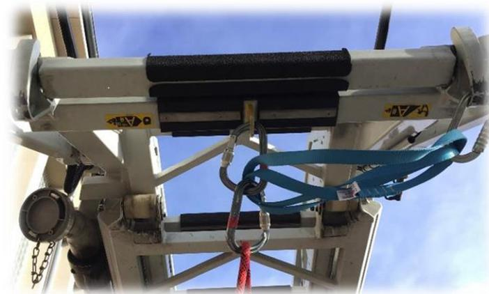
Anschlagpunkt am Leiterpark, zum Umlenken des dynamischen Kernmantelseils. Blaue Rundschlinge dient zum Verbinden der Anschlagpunkte; Redundanz der Festpunkte. Achtung: Dynamikseil muss durch einen zusätzlichen Karabiner umgelenkt werden!
