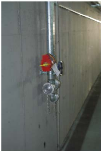
Colonne sèche (uniquement pour Rocade de Bonnevoie)
