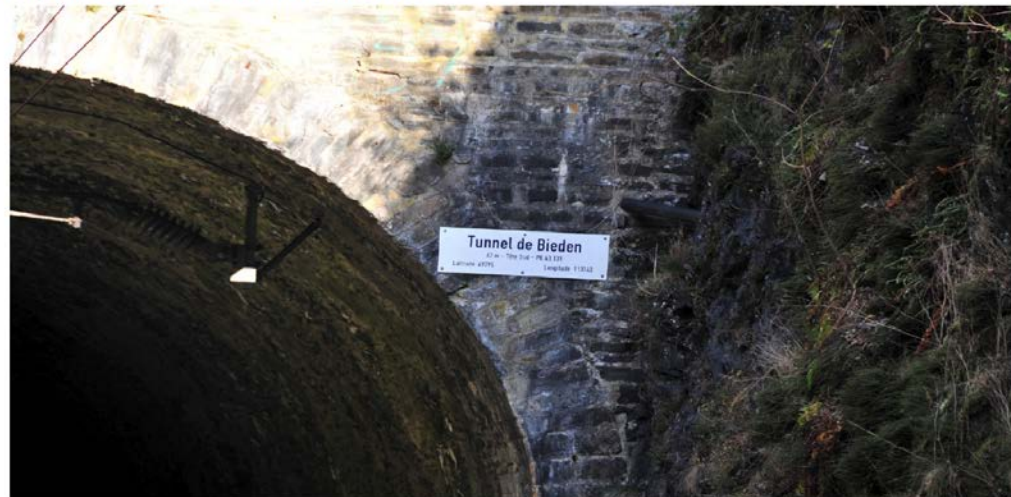
Plaques d'identification des tunnels
