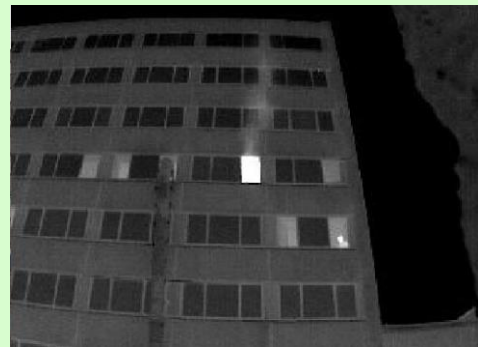
Sicht durch die Wärmebildkamera
