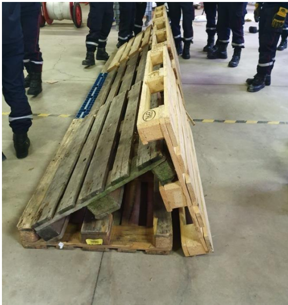
Bild 57: Grundaufbau eines Dammes mittels Europaletten
