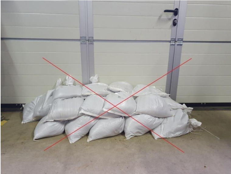
Bild 56: So sollten die Sandsäcke nicht verlegt werden
