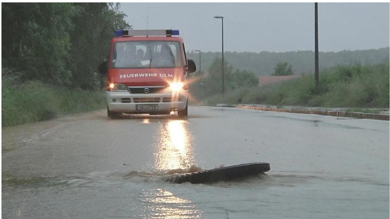
Bild 12: teilweise geöffneter Kanaldeckel, Gefahr für Einsatzfahrzeuge
