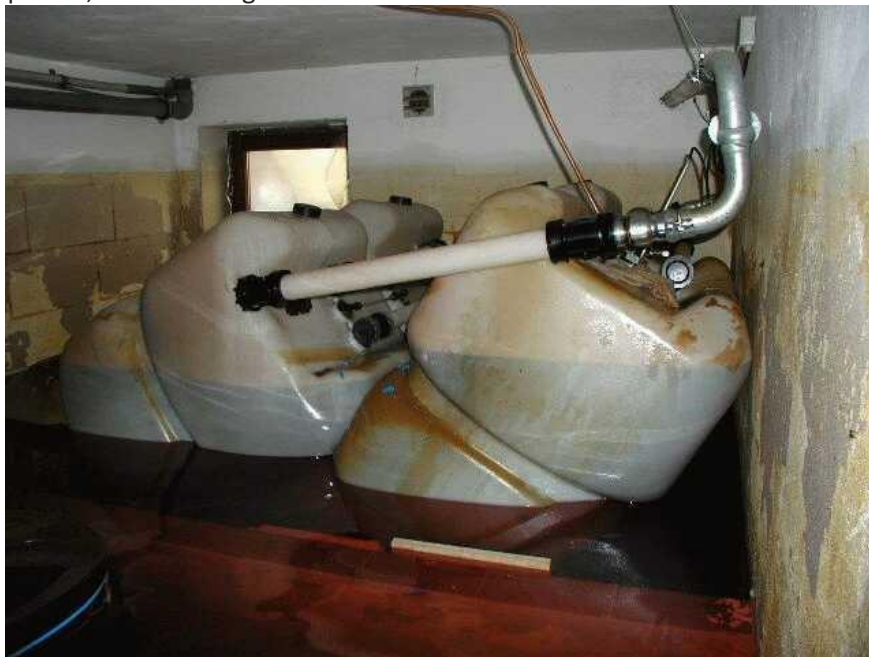
Bild 25: Umgekippter Heizöltank
