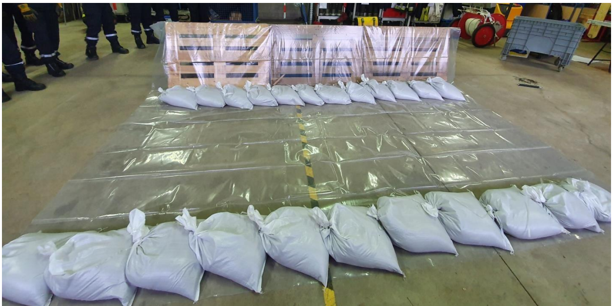
Bild 59: Ansicht von der Wasserseite auf den Damm mittels Europaletten
