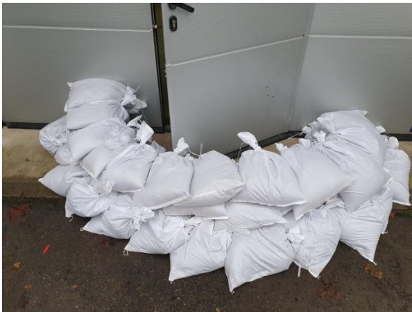
Bild 54: Sichern einer Eingangstür
