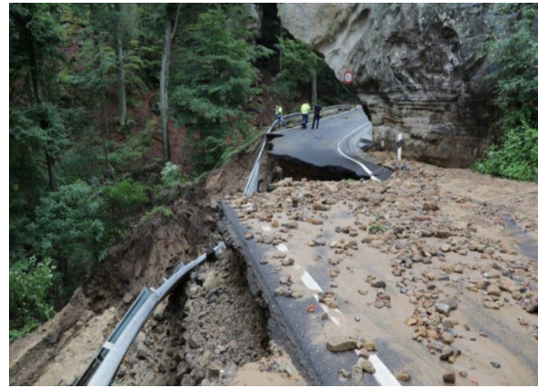
Bild 26: Unterspülte Straße zwischen Berdorf und Vogelsmühle
