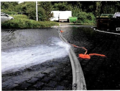
Bild 60: Leiten von Wasser mittels B-Schläuchen
