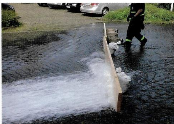
Bild 61: Wasser leiten mittels Holzbohlen oder Bierbänken
