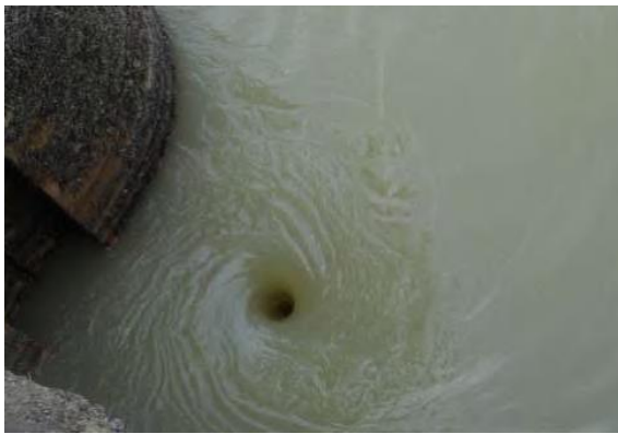
Bild 14: Strudel mit Sog bei einem geöffnetem Kanaldeckel
