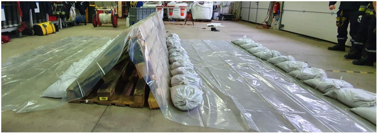
Bild 58: Fertiggestellter Damm mittels Europaletten
