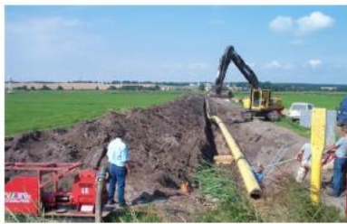
Nieder- / Mittel- oder Hochdruckleitung 50 mbar – 3,5 bar (90% PE-HD)
