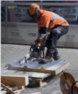
Nenn Drehzahl erreichen. Säge in stehendem Zustand
