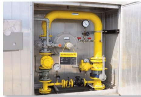
Druckreduzierstation Mitteldruck zu Niederdruck
