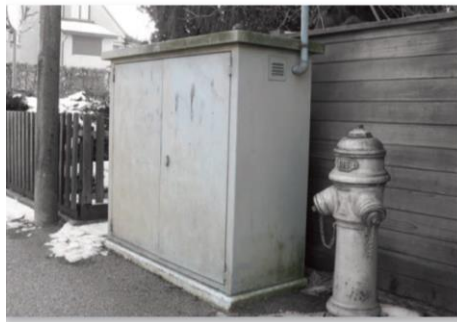
Druckreduzier- und Verteilkabine (Niederdruck)
