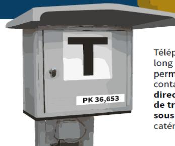
Téléphone installé le long des voies ferrées permettant de prendre contact avec le **poste directeur des circulations de trains** ou le **central sous-station** (électricité caténaire).
