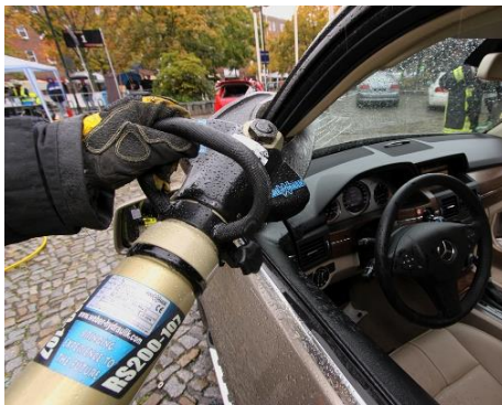
Schneiden der A-Säule
