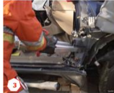
Spreizer zwischen den beiden Entlastungsschnitten einsetzen und heraushebeln.
