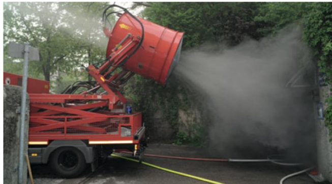
Entlüftung (Foto: Die Freiwillige Feuerwehr 4/2013)
