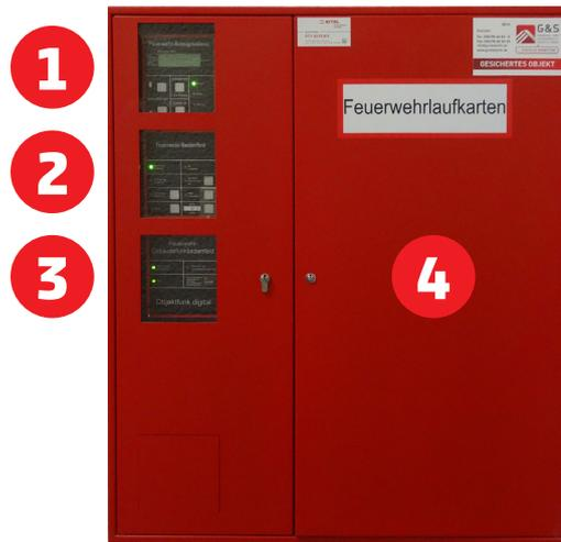
Figure 11 - Modèle d'un centre d'information pompier
