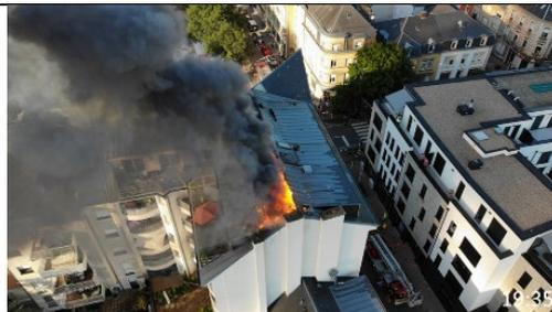
Le bâtiment de type R+6/-1 abrite des commerces au rdc et des logements dans les étages. La résidence est mitoyenne au Nord et au Sud avec d'autres bâtiments d'habitation. Seules deux façades sont accessibles aux moyens aériens. Le feu couvant dans les combles s'est rapidement propagé sur l'ensemble de la surface sans percer la toiture.
