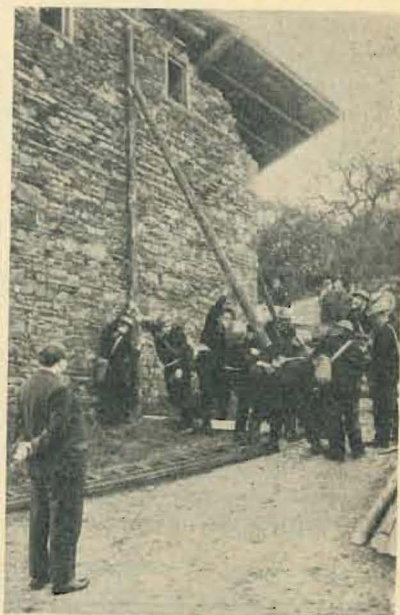
Helfer unserer Protection Civile beim Abstützen eines Gebäudes.
