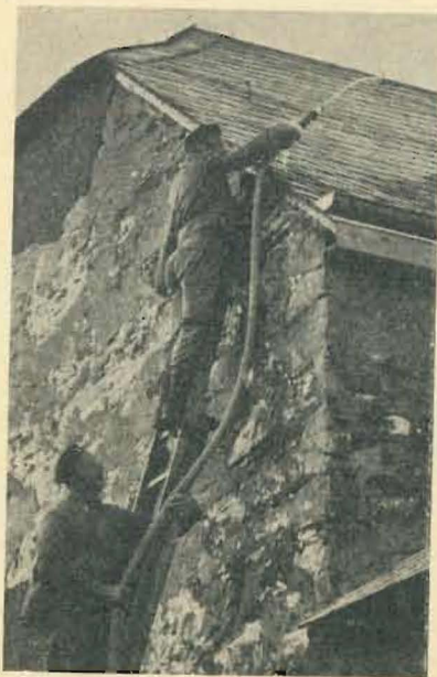
Männer der Freiwilligen Feuerwehr von Schimpach bei der Entstrahlung eines Gebäudes.
