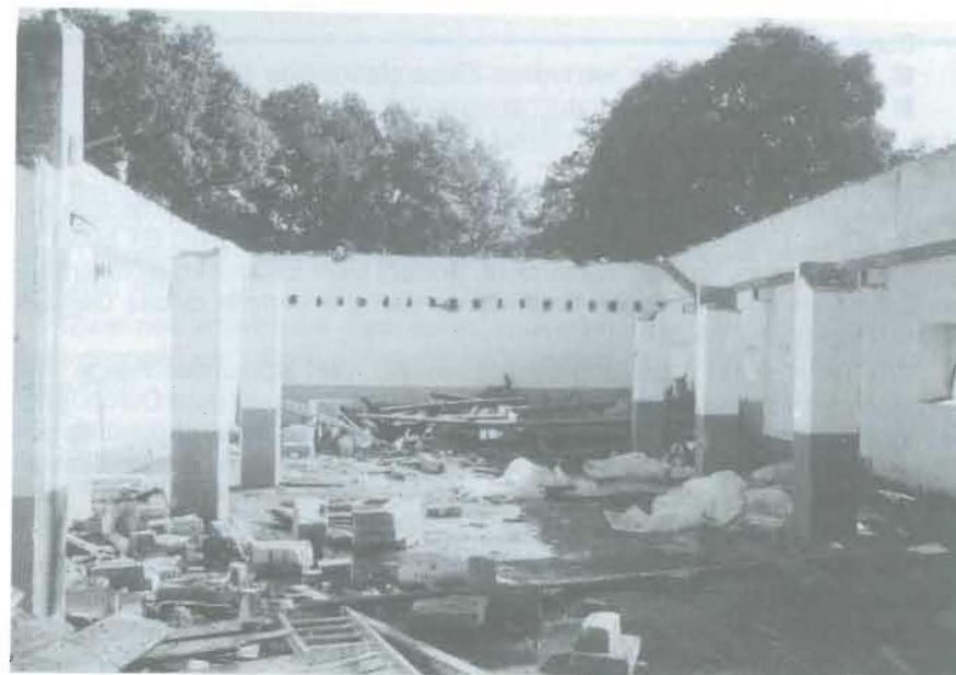
"Innenleben" des früheren Garagengebäudes am vergangenen 18. September, wenige Tage nach Beginn der umfangreichen Umbauarbeiten.
