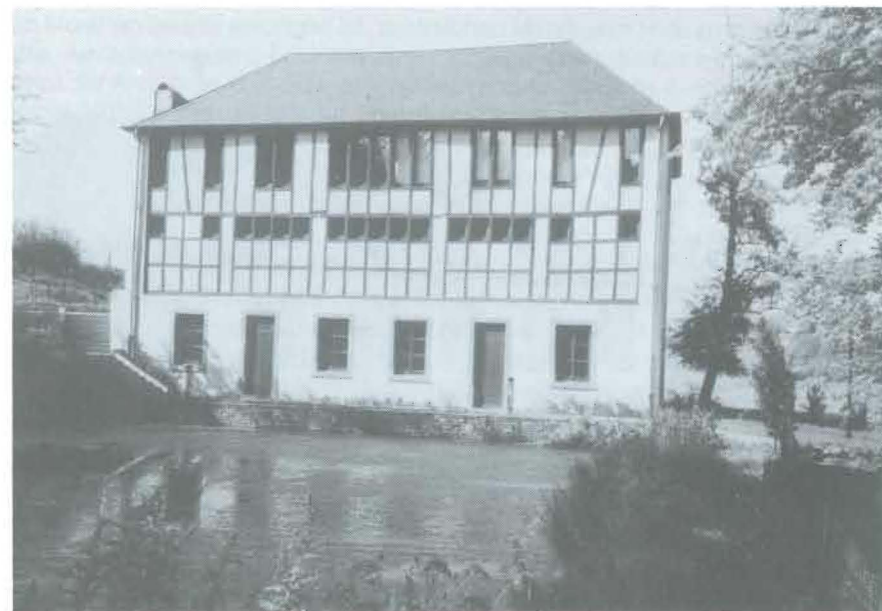
In der von der Bauverwaltung vorzüglich restaurierten früheren Gerberei hinter der Schule wurde u.a. auch eine hochmoderne Atemschutzstrecke für Übungszwecke eingerichtet.
