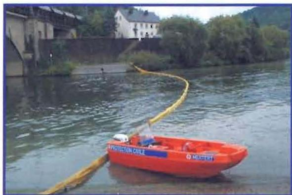
Mit großen Mengen an Sand gelang es relativ schnell die auslaufende Masse im Bett des Baches zu stauen und so einen weiteren Abfluss in die Sauer zu verhindern. Sand wurde auch rund um den beschädigten Tank aufgeschüttet und an den defekten Stellen angepresst, so dass eine relativ gute Abdichtung erreicht wurde. An der Mündung der Sauer in die Mosel wurde eine Ölsperre errichtet.
