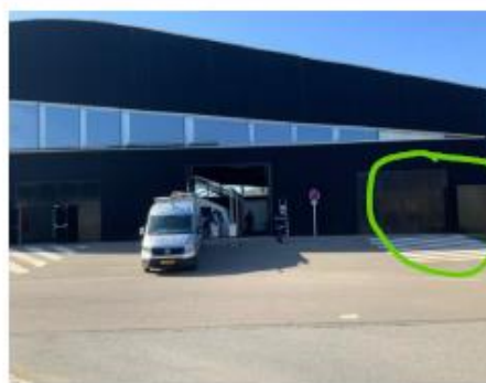
Porte d'accès ambulance avec zone de stationnement
